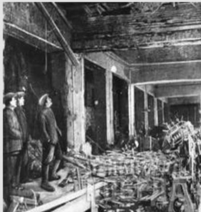
Разрушенный цех завода
